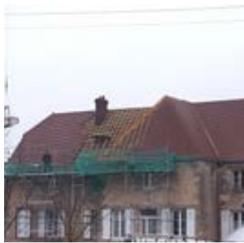
TOITURE DU GROUPE SCOLAIRE
