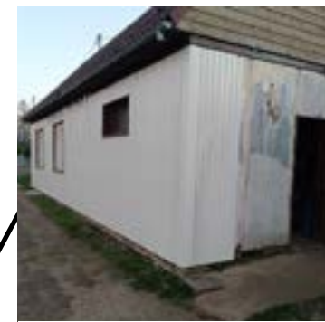
RÉFECTION DU CLUB HOUSE DU FOOT
