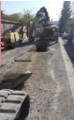
RUE PINCELOUP, RUE L'ABBÉ DAVID & PASSAGE DU JEU DE PAUME Mise en séparatif du réseau d'assainissement (par la communauté de communes).
