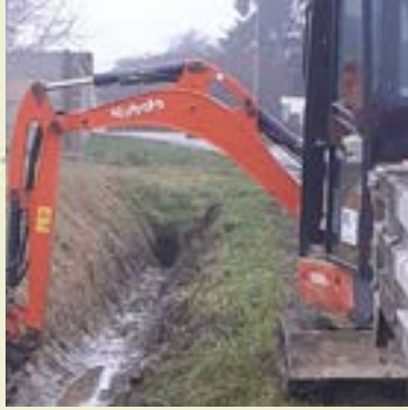
RUE D'ALIGRE Curage du fossé pour favoriser l'écoulement des eaux pluviales.
